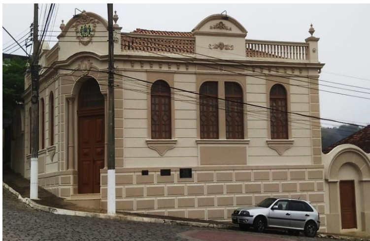
Foto 22: Detalhe do Paço Municipal, após as obras de pintura externa em 2019.
