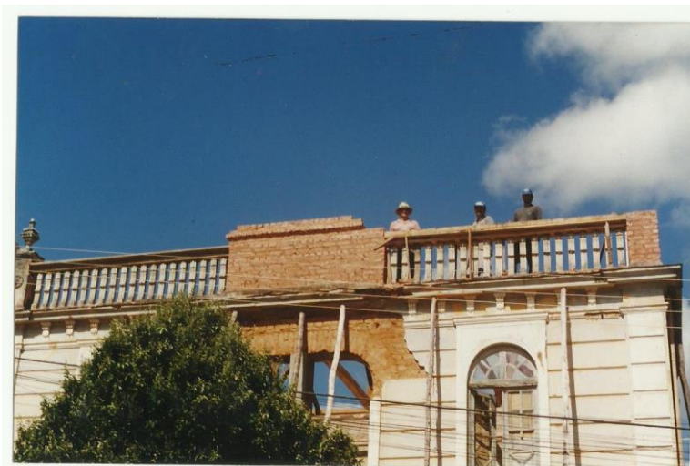
Foto 18: Detalhe das obras de restauração do Paço Municipal, na fachada no ano 2000.
