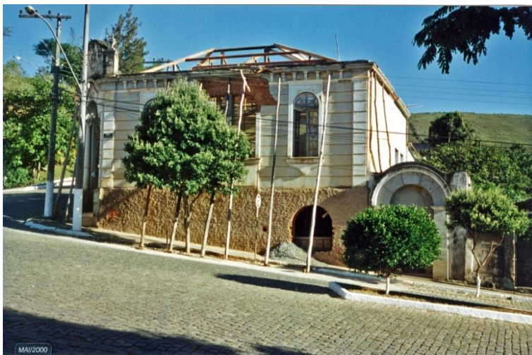
Foto 19: Detalhe do andamento das obras de restauração do Paço Municipal em Maio/2000 a partir da Praça do Divino.
