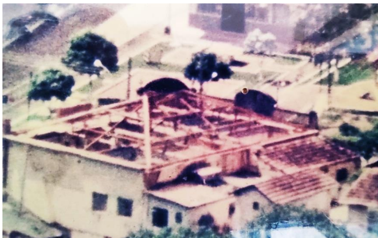
Foto 17: Detalhes das obras de reconstrução do telhado do Paço Municipal, no ano 2000.
