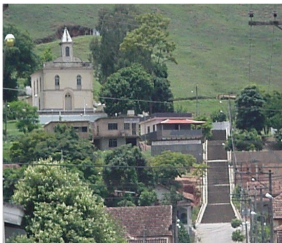
Escadaria da Capela de São Sebastião
