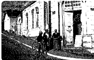
Foto 17 - Vista frontal do Paço Municipal, em 1984, com o prefeito Antero Dias da Rocha ao lado da porta. Nessa foto, é possível identificar desgastes na parte externa do imóvel.
