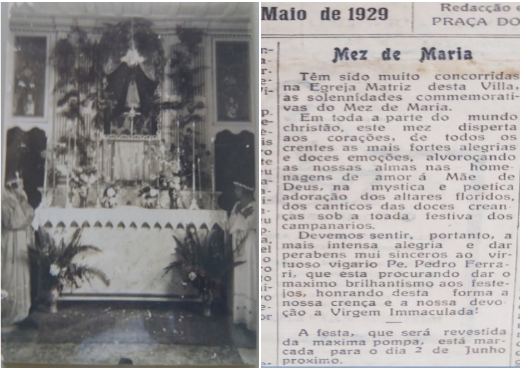
Foto 09: Detalhes da Antiga Capela do Santíssimo, em data desconhecida.
