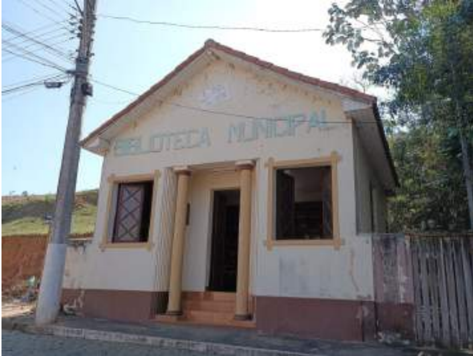
Antes da Pintura
